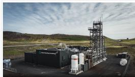
Diese Anlage am Geothermie-Kraftwerk Svartsengi ist die erste weltweit, die Kohlendioxid in industriellem Maßstab zur Produktion von Methanol nutzt. Vergrössern und weitere Fotos aus Island mit Klick auf Bild!
