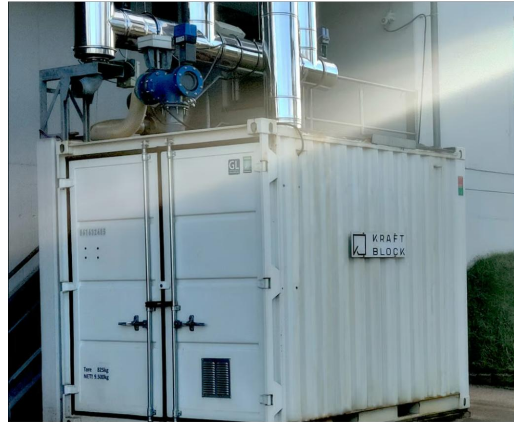
Kraftblock-Wärme-Container: Wärmespeicher in der Keramikindustrie und Baustellentrocknung mit bis zu 1300 Grad
