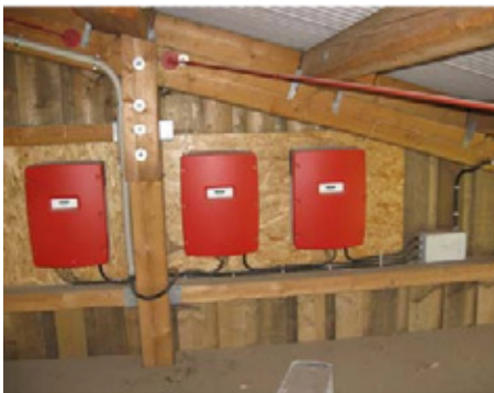
Montage der Wechselrichter auf brenn barem Untergrund nur mit schriftlicher Genehmigung des Herstellers. Im Brandfall hohes Schadenpotenzial.
