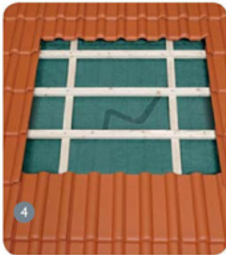
Deckung wird entfernt
