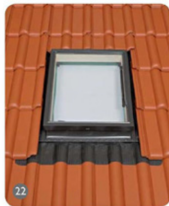
fertig eingebautes Dachfenster
