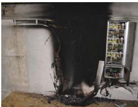
Brand nach Kurzschluss (Ursache: lose Klemmstelle durch falsch eingelegtes Gewindeplättchen)
