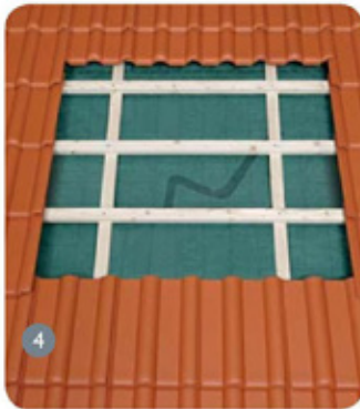
Deckung wird entfernt
