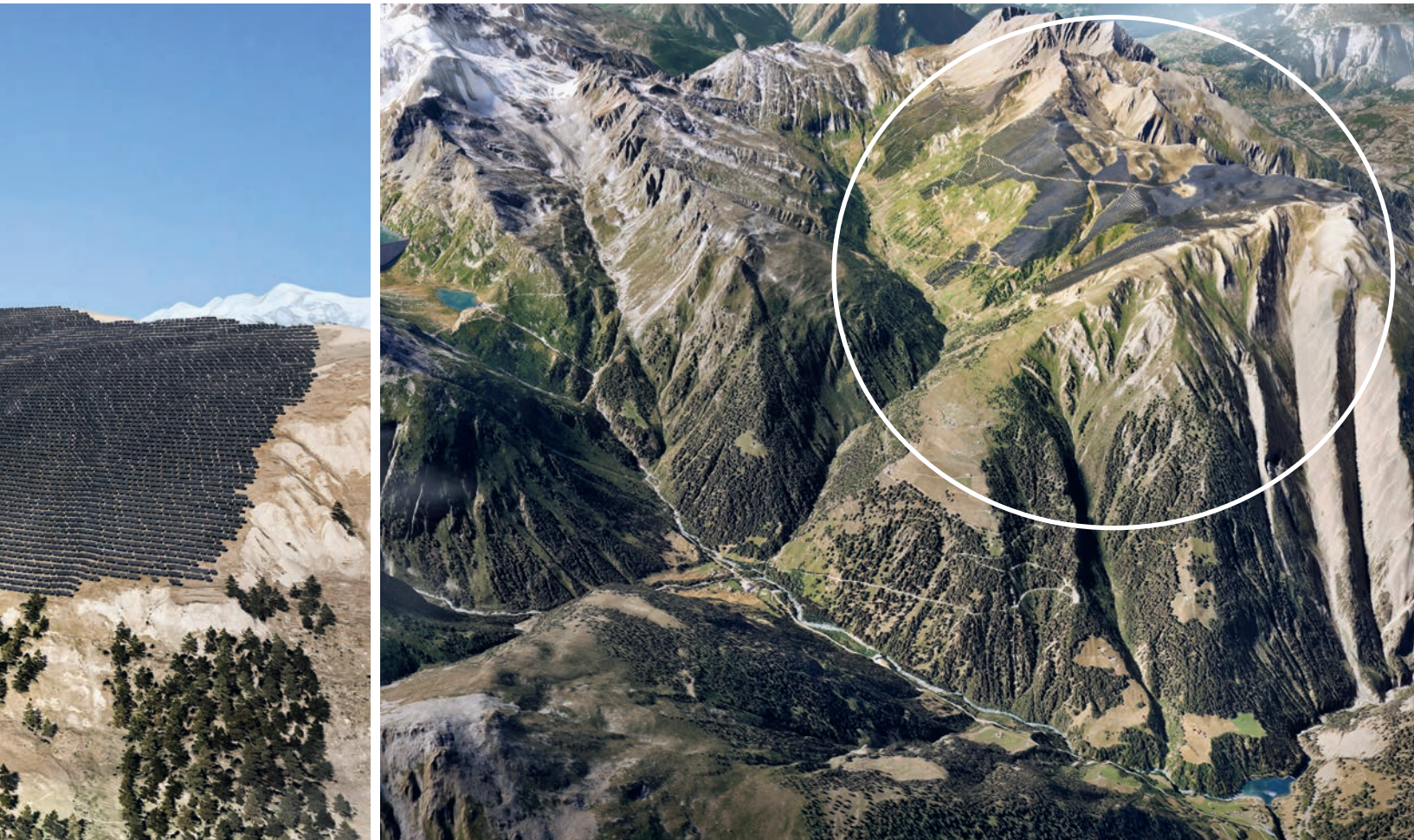
Ob Grenchols VS auf bis 2500 m ü. M. könnten im Endausbau auf 3,4 km 2 Fläche 910 000 Solarmodule (wie hier im Bild dargestellt) mit einer Leistung von 440 MWp dereinst jährlich 600 GWh Strom liefern. Ende 2023 will Grenchols-Solar ein erstes Bauprojekt einreichen für 160 000 Solarmodule mit einer Leistung von 80 MWp. (grenchols-solar.ch)
