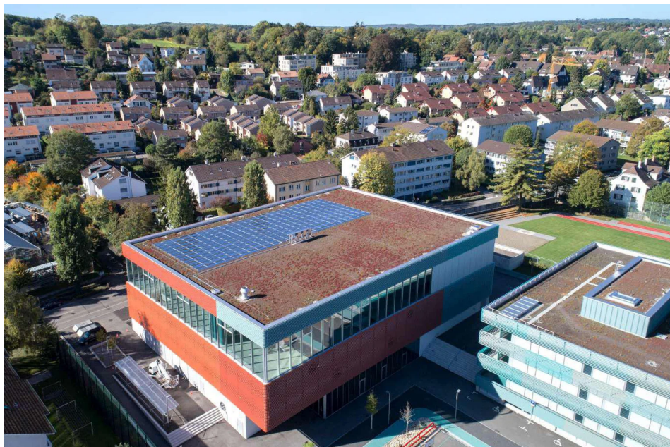
Ein häufiges Bild in der Schweiz: Nur teilweise mit Solarzellen bestücktes Turnhallendach in Allschwil (BL). bild: adev, liestal
