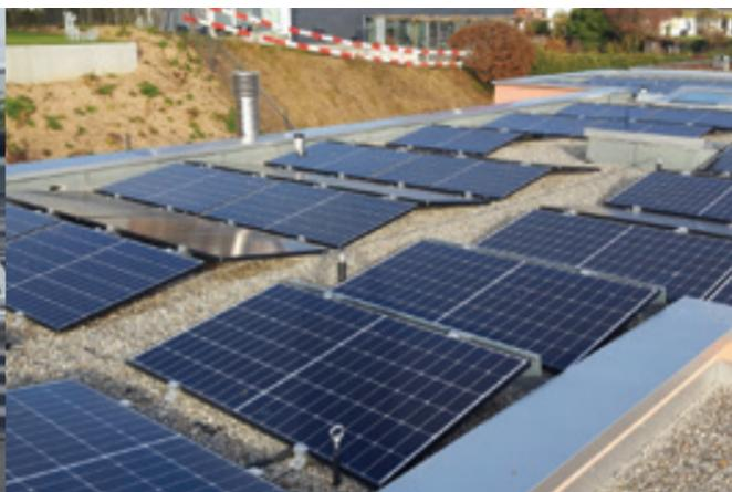
Modules montés avec la couverture en gravillon
