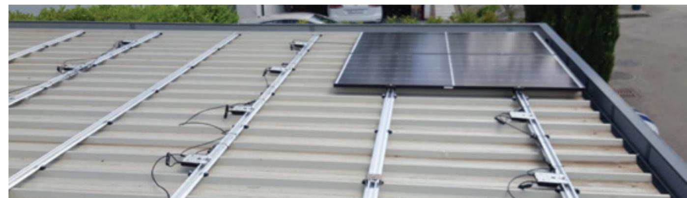
Installation PV sur carport en tôle trapézoïdale : les rails sont directement vissés à la tôle
