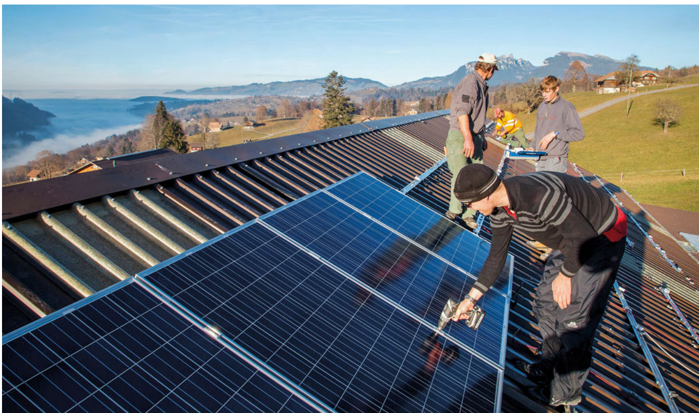
Das gemeinsame Arbeiten auf dem Dach gehört zum Selbstbau mit der Energiegendegenossenschaft Spiez dazu.
